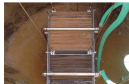
Die plattenförmigen Membranen sind parallel angeordnet.
