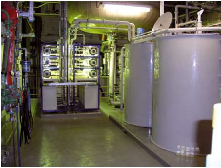
Die UV-Oxidationsanlage kann sich automatisch dem jeweiligen Volumenstrom des Abwassers anpassen.
