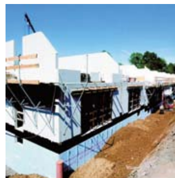
Reihenhausrohbau aus Kalksandsteinen
