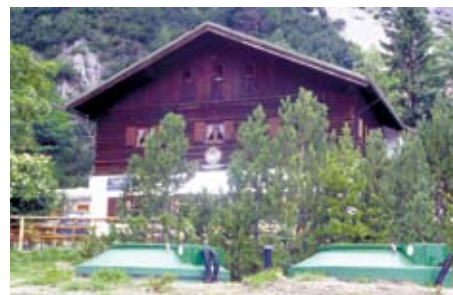
Die Wimbachgrieshütte – im Vordergrund die Kammern der neuen Kläranlage
