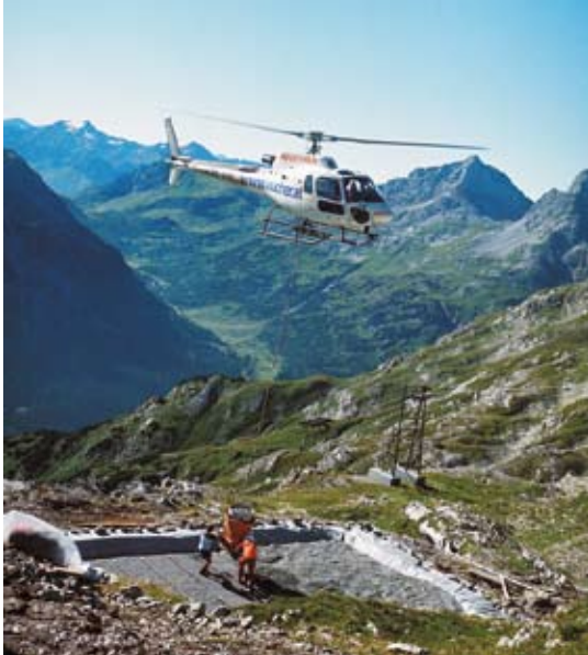
Bau der Abwasserreinigungsanlage Göppinger Hütte (2245 m. ü. NN. Vorarlberg, Österreich), Kooperationspartner OtterWasser GmbH
