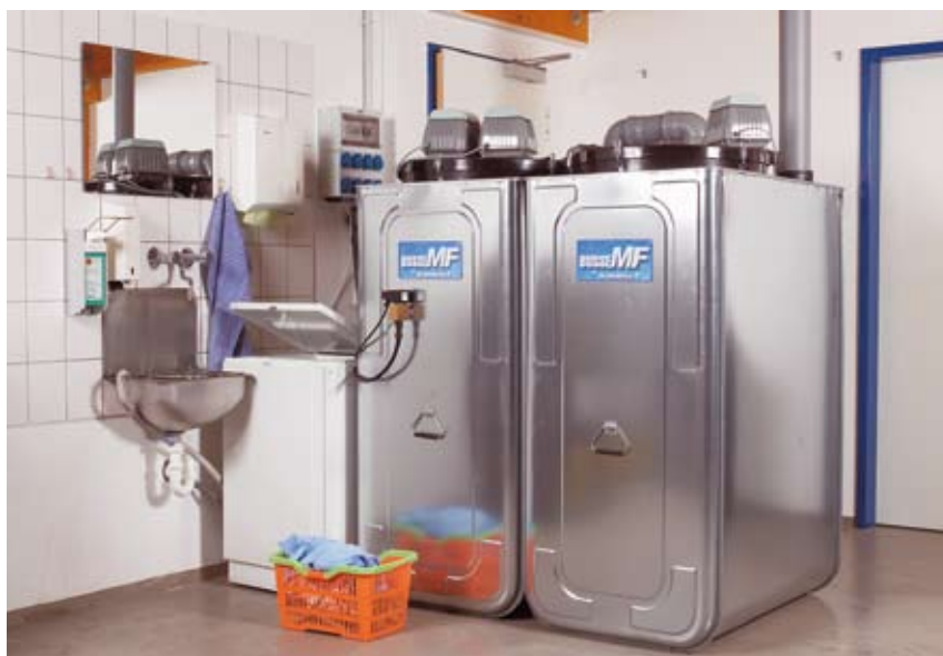
Die Kleinkläranlage BUSSE-MF reinigt häusliches Abwasser bis auf Badewasserqualität.
