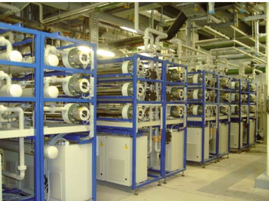
Enviolet® UV-Anlagen werden zur Behandlung von Prozessströmen, Wasser und Abwasser erfolgreich eingesetzt.
