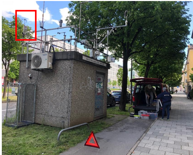
Abbildung A 3: Das relevante Ultraschallanemometer des LfU auf der LÜB-Station nahe der Straße auf ca. 3,5 m.
