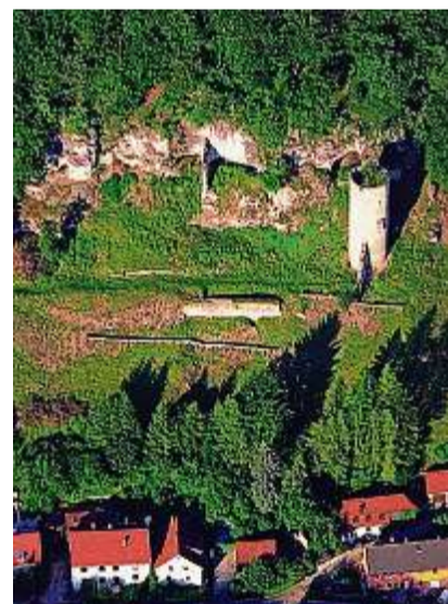
Die Burgruine Loch vor der umfassenden Sanierung
