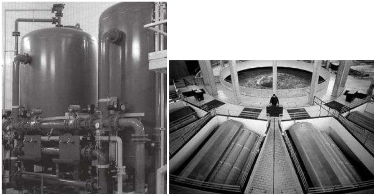
Abbildung 2: Druckfilteranlagen und Mikrosiebe zur Wasseraufbereitung (Mutschmann, Stimmelmayer: Taschenbuch der Wasserversorgung, 2007)
