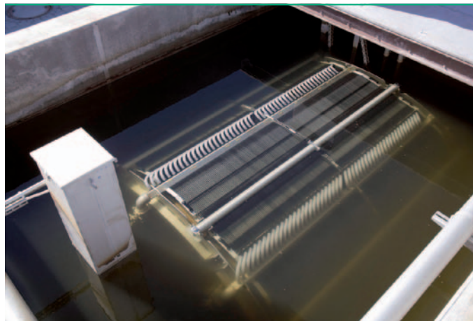
Abb. 2: Mit moderner Membrantechnik lässt sich Abwasser sehr sauber aufbereiten: Sogar Bakterien und teilweise auch Viren werden herausgefiltert.
