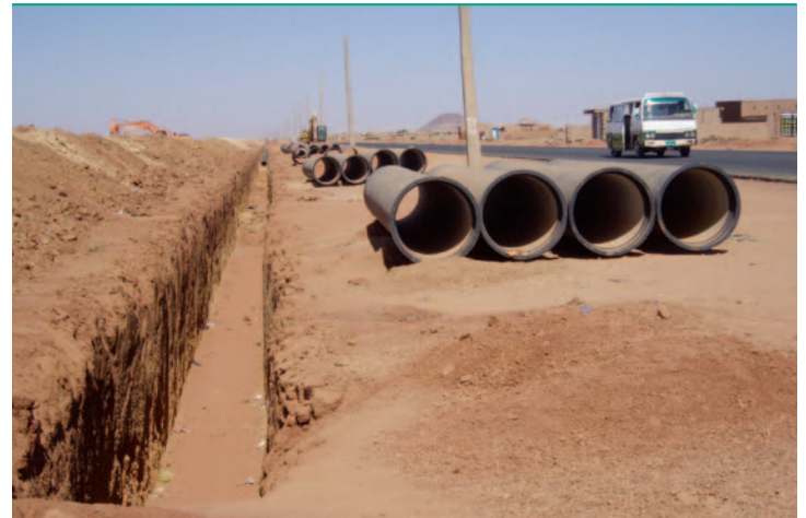
Abb. 8: Installation von Wasserleitungen in Thoura, September 2010.
