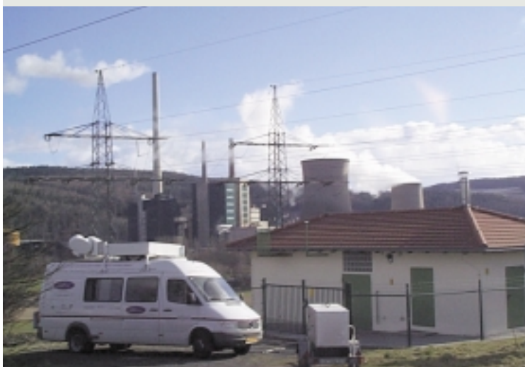
LIDAR-Messwagen vor einem Kraftwerk
