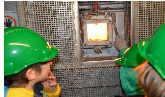
Blick in den Verbrennungssofen
