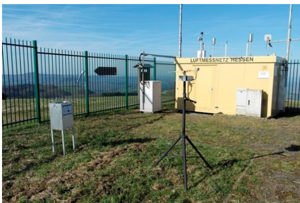
Die Niederschlagssammler, die Aerosolprobenahme und die Luftmessstation auf einem Bild.
